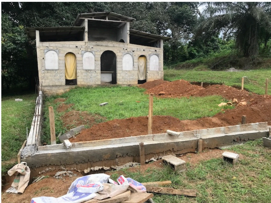
La construction de la chapelle de saint Jean le Précurseur à Omog au foyer continue enfin
