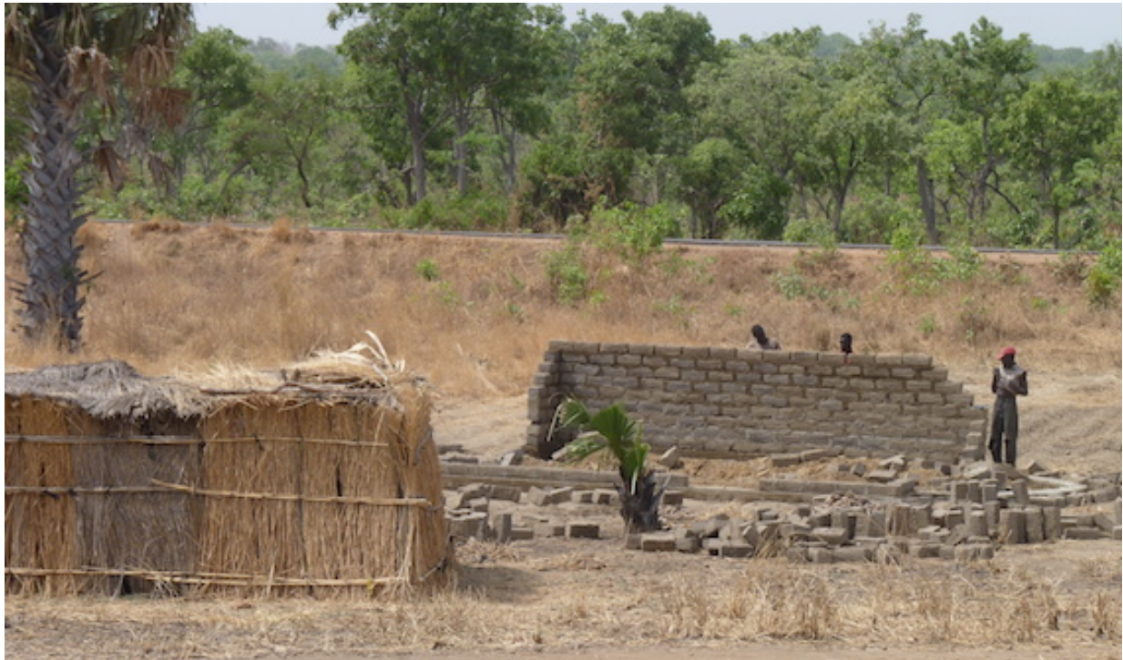
l'ancien chapelle et la nouvelle en construction
