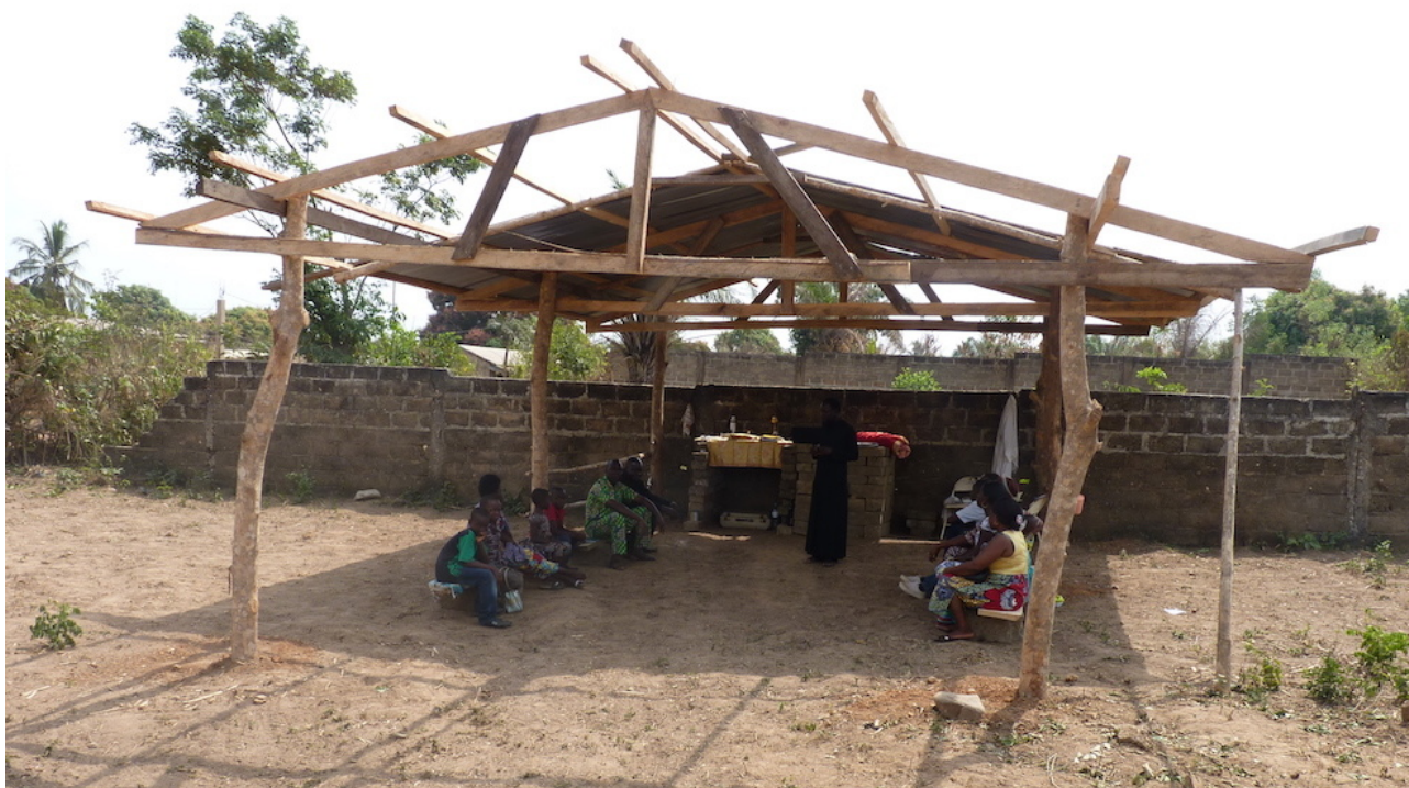
La chapelle en reconstruction
